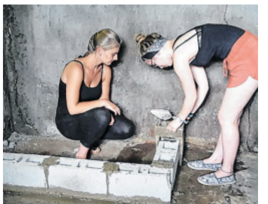
Stein auf Stein: Die Jugendlichen helfen dabei, holzbetriebene Öfen zu bauen.
